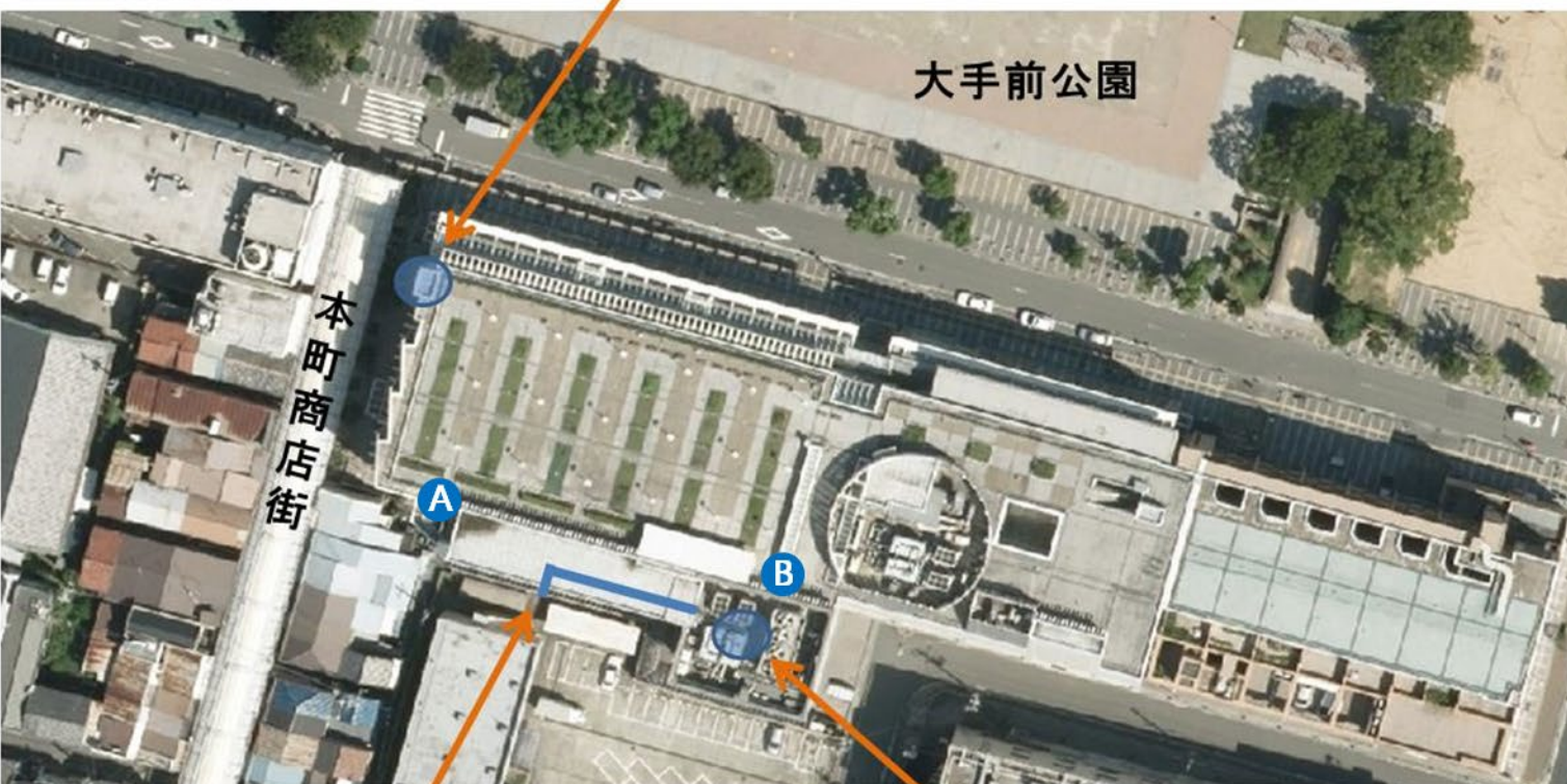
屋上からケーブルを落として、 3階のパントリーの窓へ引き込む
